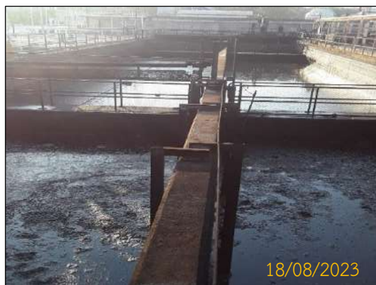
ภาพที่ 2.1-32 API Separator ที่สถานีผลิตลานกระบือ
