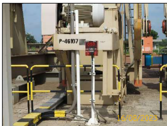
ภาพที่ 2.1-37 อุปกรณ์หยุดการทำงานฉุกเฉิน (OSD/ESD)
