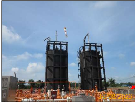
ภาพที่ 2.1-30 ถังเก็บน้ำมันดิบที่มีคั่นคอนกรีตล้อมรอบ
