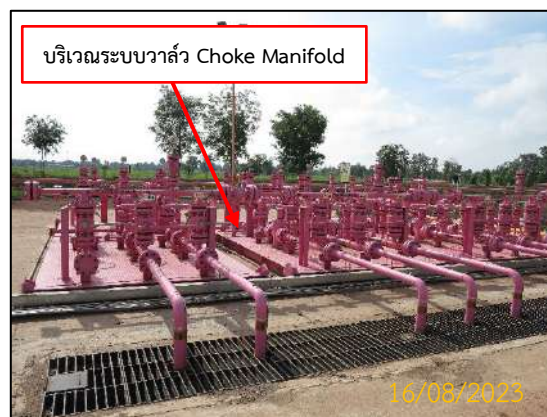
ภาพที่ 2.1-5 ระบบวาล์วบริเวณหัวบ่อ Christmas Tree และ Choke Manifold
