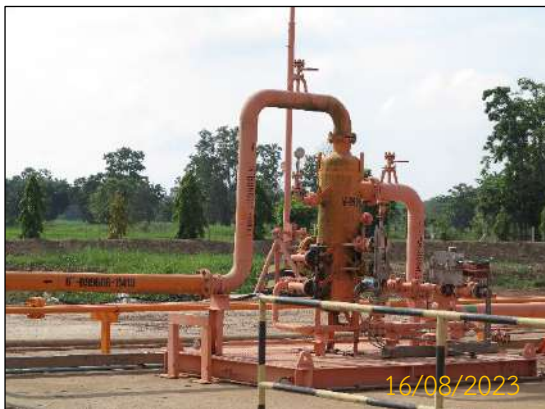
ภาพที่ 2.1-4 เครื่องดักอนุภาคไฮโดรคาร์บอน (Flare Knock Out Drum)
