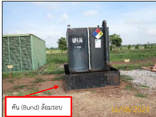
ภาพที่ 2.1-13 ถังเก็บน้ำมันดีเซล
