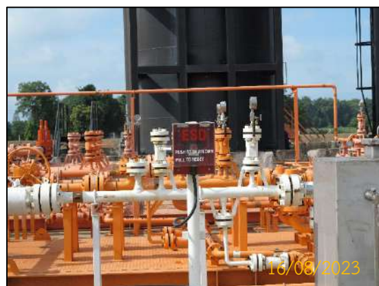
ภาพที่ 2.1-37 อุปกรณ์หยุดการทำงานฉุกเฉิน (OSD/ESD)
