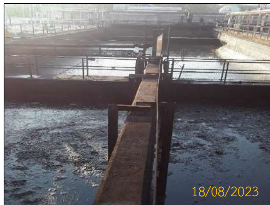
ภาพที่ 2.1-14 API Separator ที่สถานีผลิตลานกระบือ
