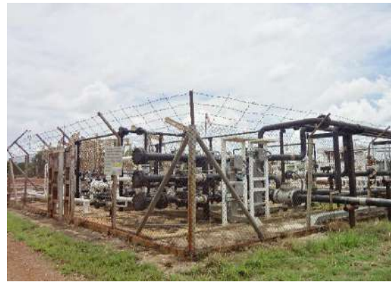
ระบบควบคุมความดันในเส้นท่อ (Manifold)
